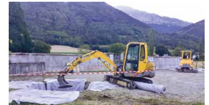
Juil. 2020 Travaux de drainage
