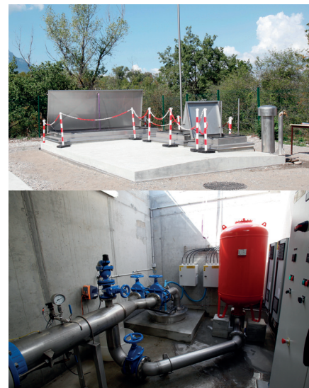
Le nouveau puits de captage va puiser l'eau à 50 mètres dans le sous-sol, dans la nappe alluviale du Drac.
