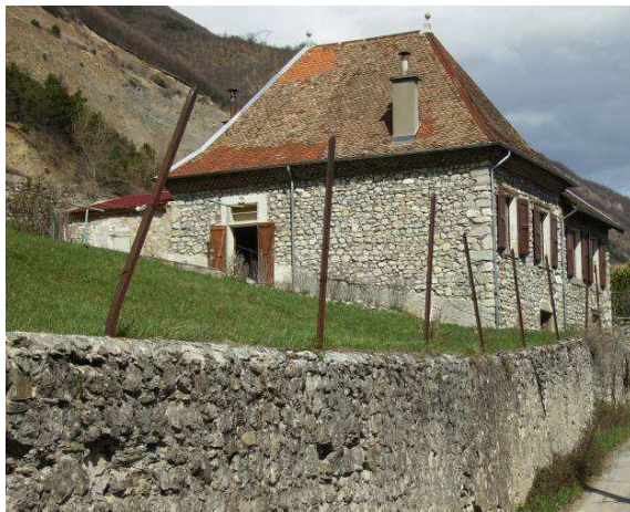
Maison VICAT qui accueillera le futur centre du Tichodrome. © Le Tichodrome
